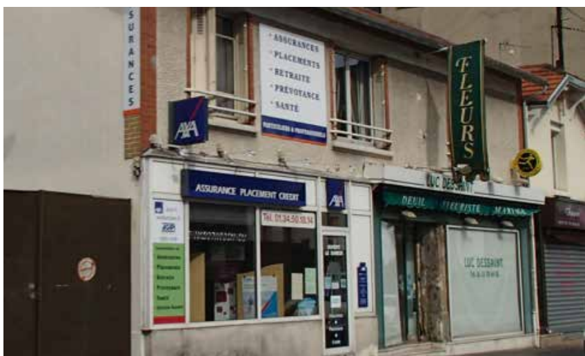
ENSEIGNES SANS LIEN AVEC LES FAÇADES - CORMEILLES-EN-PARISIS
