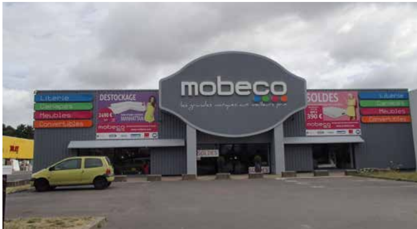
ENSEIGNE EN FAÇADE DÉPASSANT DU MUR
